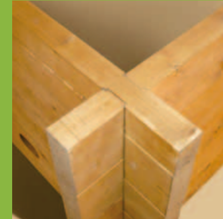
PARETE STRUTTURALE IN massiccio
